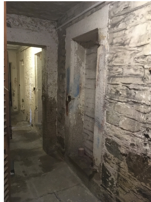
Existing Cell Door
